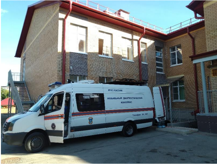
Здание сложной Н-образной формы без деформационных швов на насыпных грунтах, фундамент ленточный
