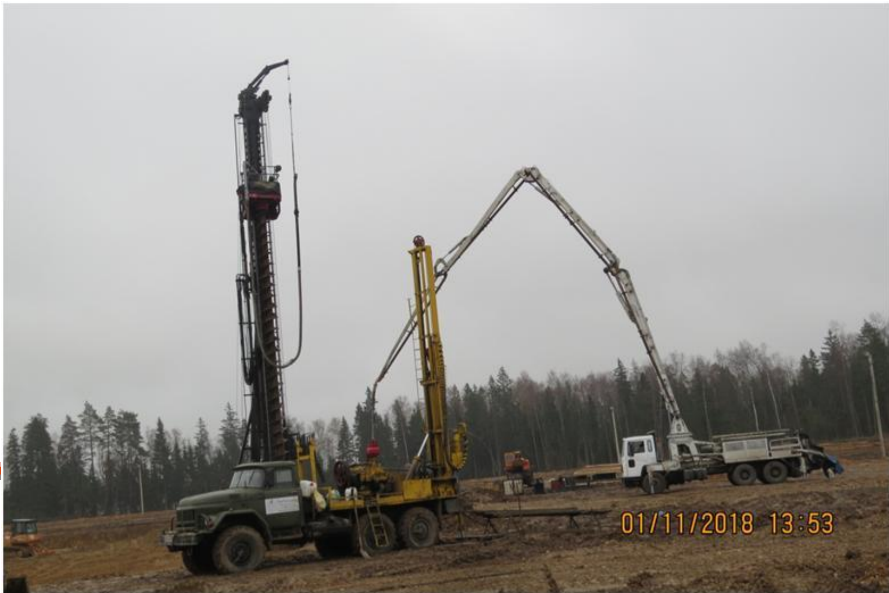
Производство свай по технологии НПС на месте строительства
