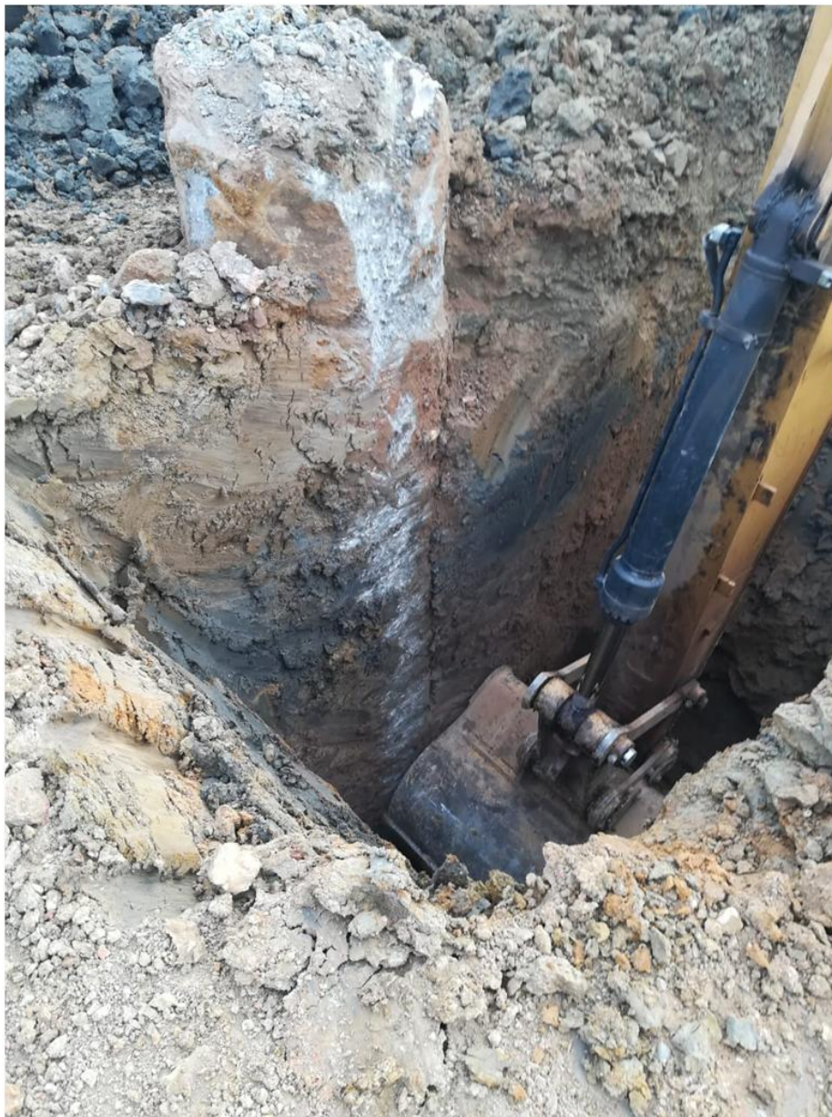
Откапывание изготовленной сваи для проверки её состояния
