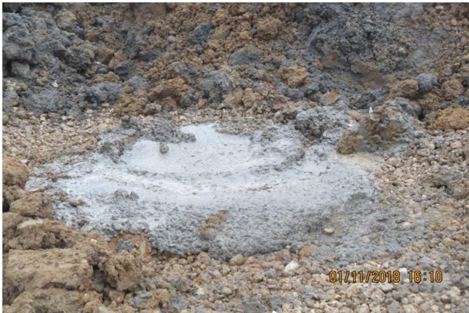
Скважина заполненная бетоном.
