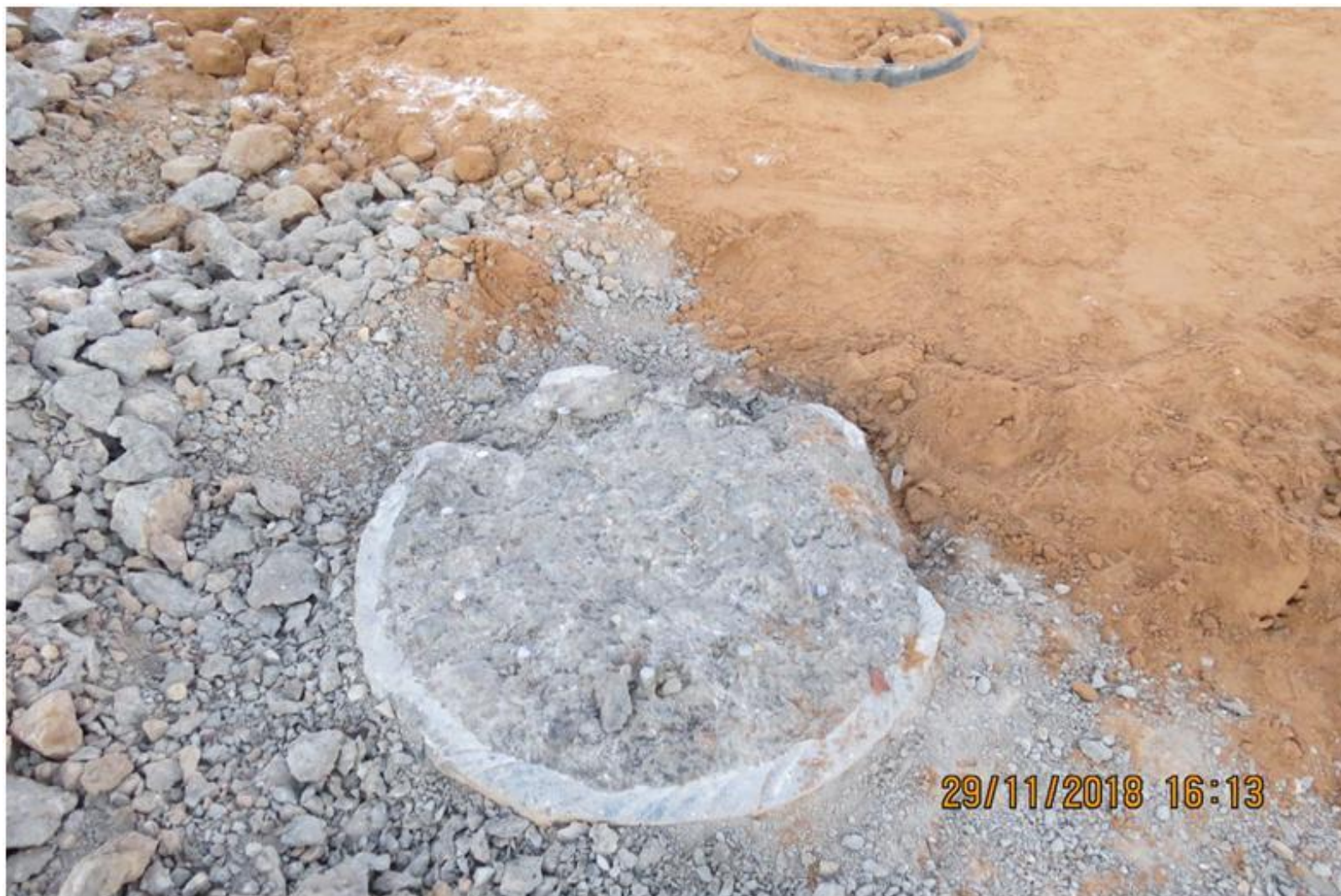
Оголовок сваи изготовленный по технологии НПШ
