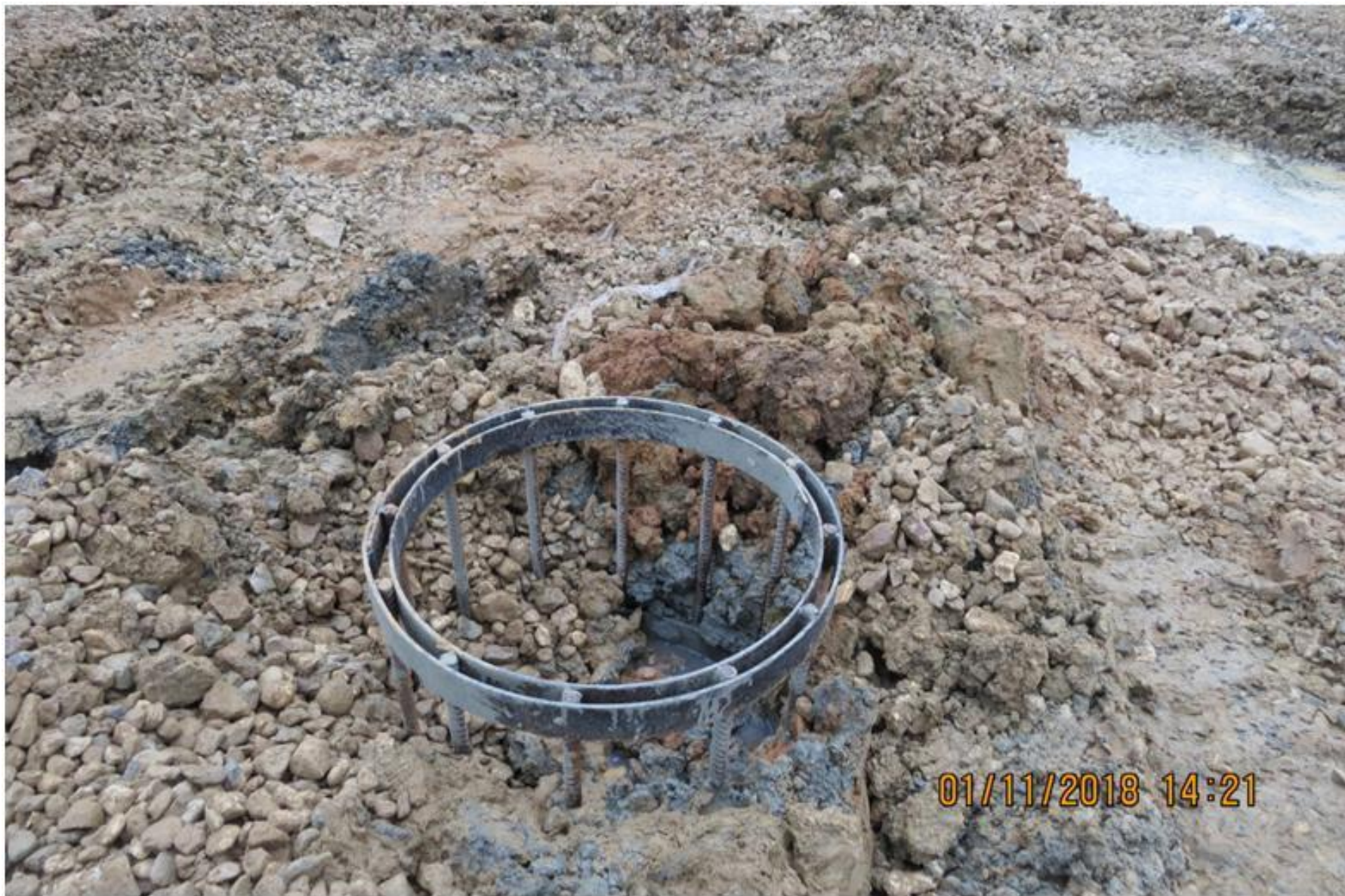
П о г р у ж е н н ы й а р м о к а р к а с
