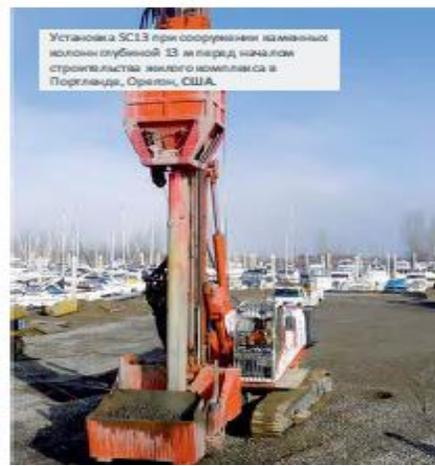
Установка SC13 при сооружении каменных колонн глубиной 13 м перед началом строительства жилого комплекса в Портленде, Орегон, США.
