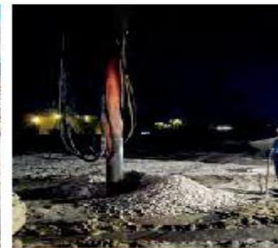
Использование вибропик в ночную смену при сооружении каменных колонн глубиной 12 м на проекте расширения бумажной фабрики CELBI в Португалии.
