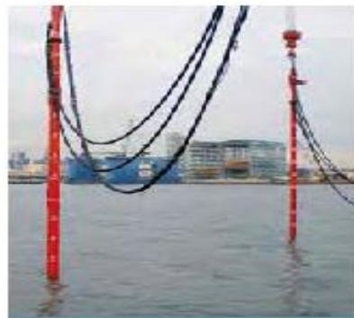
Работа двух вибропик при уплотнении 17 млн куб.м. песчаного грунта под водой на глубине от 15 до 20 м. Уплотнение грунта требуется для строительства нового причала длиной 6 км. **Сенгалур.**
