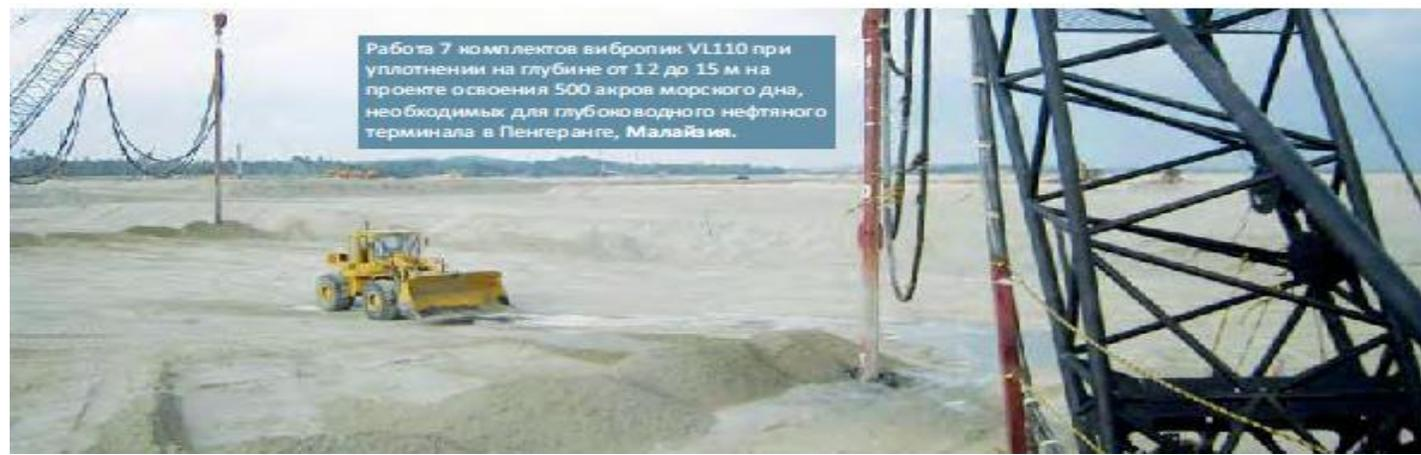
Работа 7 комплектов вибропик VL110 при уплотнении на глубине от 12 до 15 м на проекте освоения 500 акров морского дна, необходимом для глубоководного нефтяного терминала в **Пенгеранге, Малайзия.**
