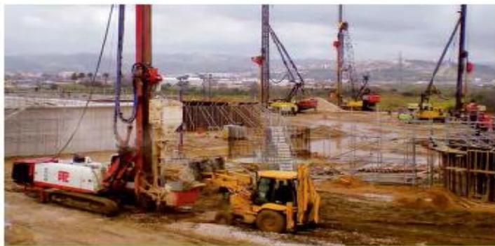
Установка SC13 и 3 комплекта вибропик VL18 BFS при сооружении 6500 каменных колонн на проекте по расширению нефтеперерабатывающего завода в Синде, Алжир.
