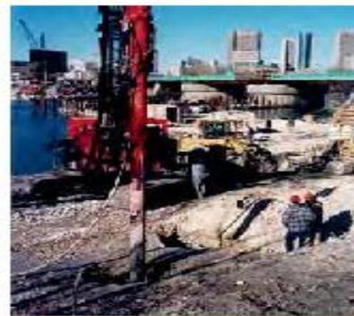
Установка при помощи вибропик компании PTC 5 ниток каменных колонн глубиной 10 м на участке 2 км вдоль берега реки Ред-Ривер, Виннипег, Канада.
