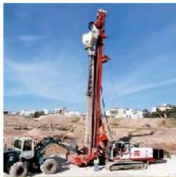
Установка SC13 компании PTC при сооружении 1500 каменных колонн глубиной 11,5 м и диаметром 800 мм для нового культурного центра в Афинах, Греция.
