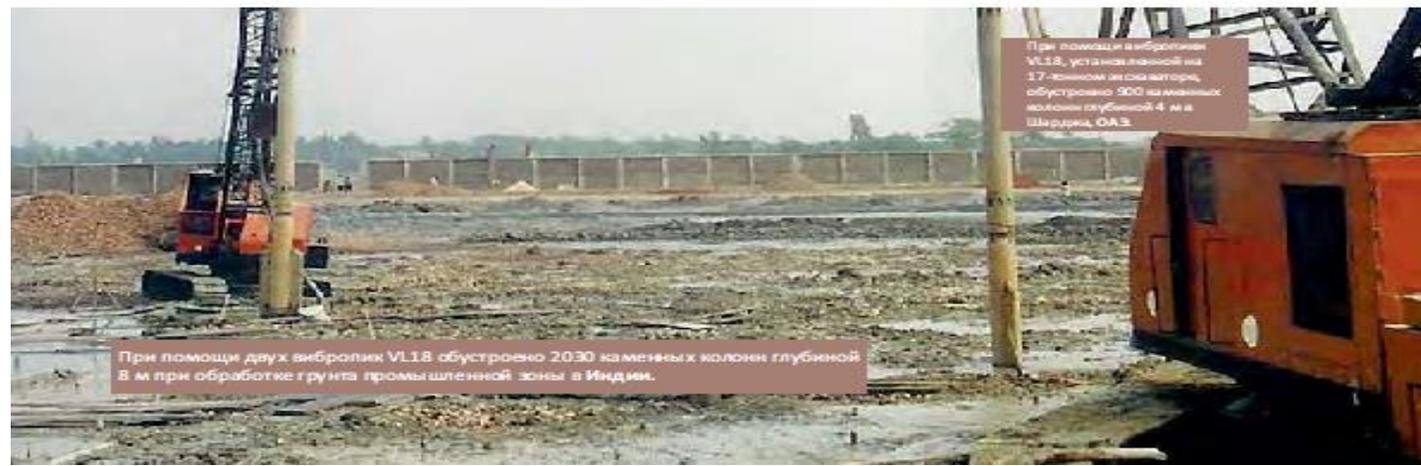
При помощи двух вибропик VL18 обустроено 2030 каменных колонн глубиной 8 м при обработке грунта промышленной зоны в Индии.
