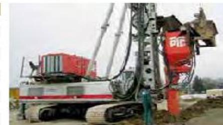
Вибропика VL18 BFS, смонтированная на мобильной установке с энергетической станцией компании PTC (155 кВт), при сооружении каменных колонн глубиной 8 м и диаметром 600 мм, Франция.
