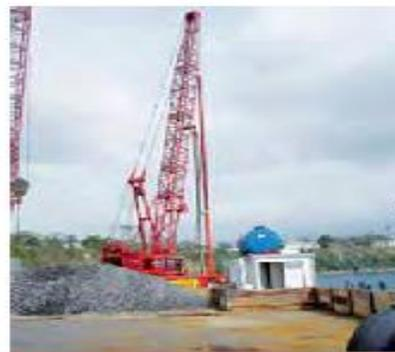
Работа двух вибропик при сооружении каменных колонн методом верхней подачи под водой на глубине 17 м в гавани Малабо, Экваториальная Гвинея.
