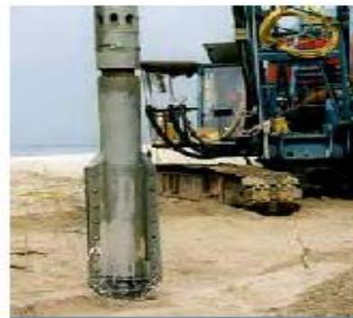
Работа вибропика VL110 на глубине 31 м при уплотнении 2 млн куб.м. грунта при расширении электростанции на острове **Лампа, Гонконг.**
