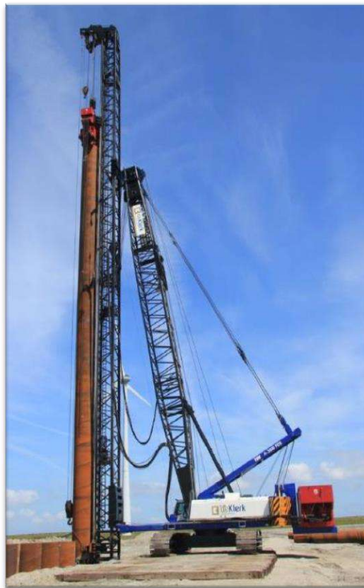
ОБОРУДОВАНИЕ ТИПА PDS (ЛИДЕРНЫЕ СТОЙКИ НА ОСНОВЕ ГУСЕНИЧНЫХ КРАНОВ)
