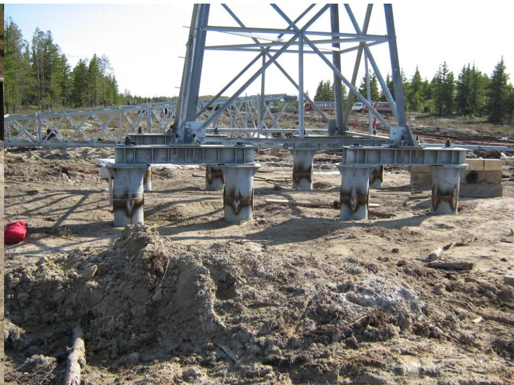
Широкобазная опора на многосвайном фундаменте
