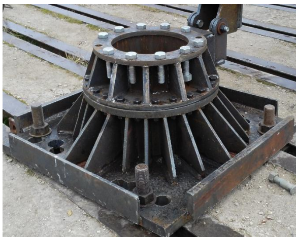
Узел крепления к силовому полю
