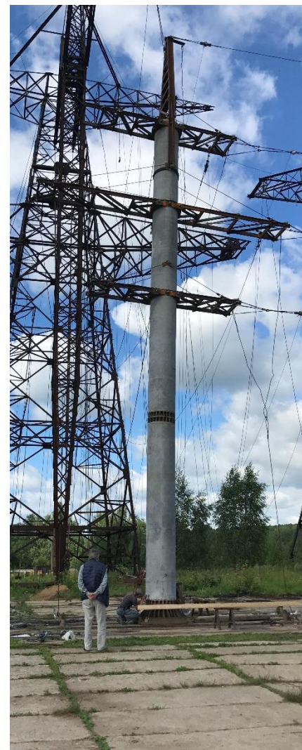
Двухцепная анкерно-угловая опора
