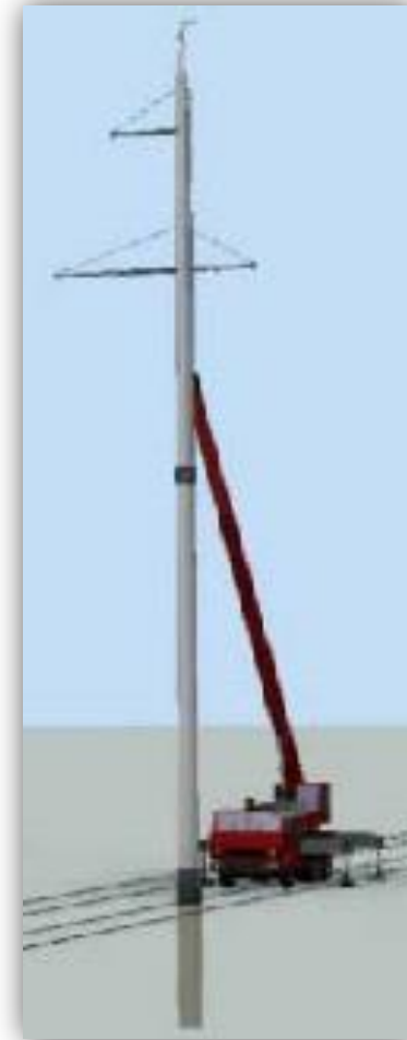
Установка железобетонной секционированной опоры на фундамент
