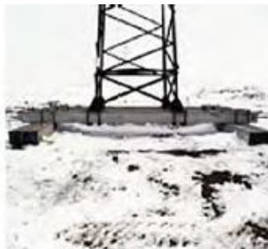
Сооружение поверхностных фундаментов
