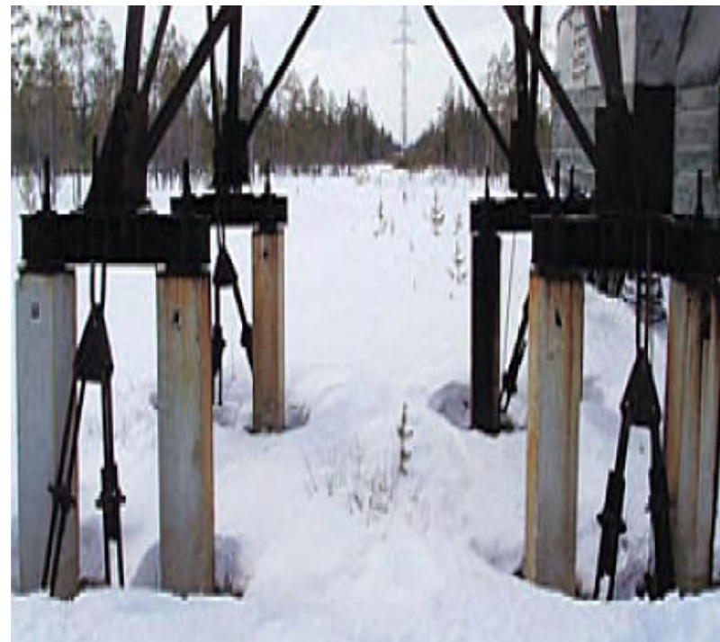
Сооружение поверхностных фундаментов
