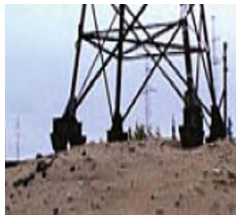
Обваловка грунтом фундаментов опор.
