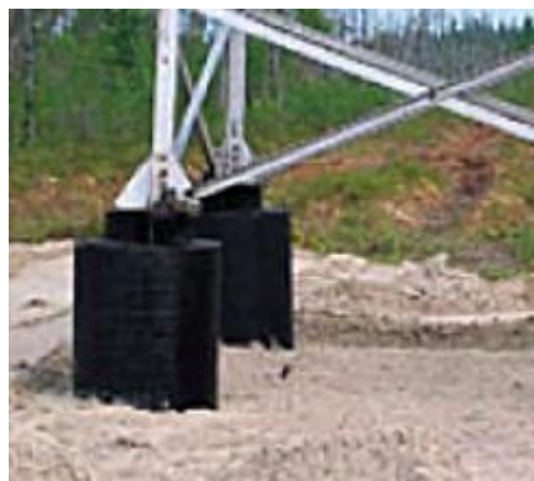
Ремонт свай фундаментов протекторным методом, подверженных разрушению бетона.
