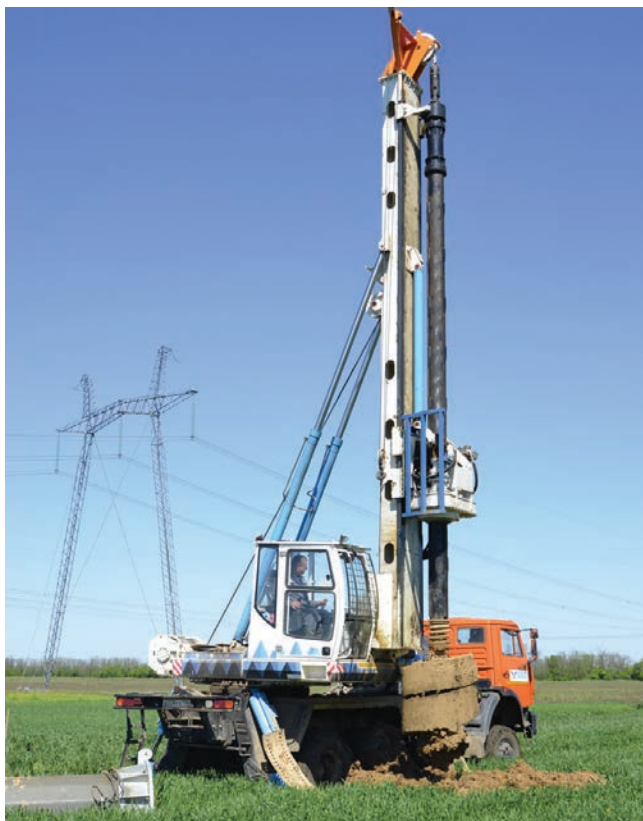
Рис. 2. БКМ-2012. Бурение штангой-Келли для установки свайной оболочки.
