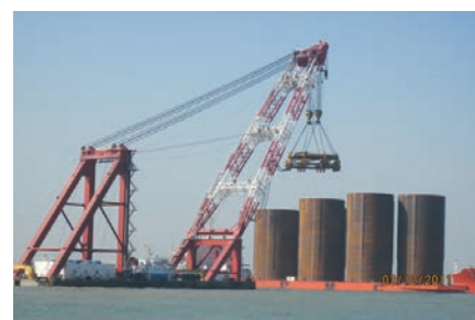
Рис. 9. Транспортировка на плавсредствах готовых сваи-оболочек к месту погружения
