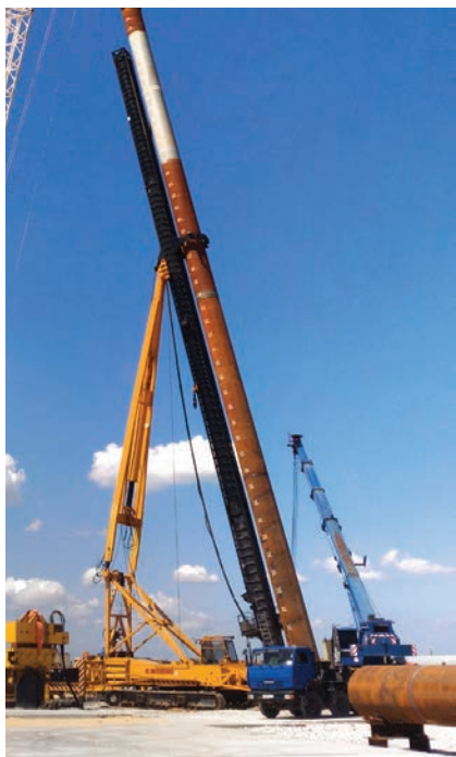
Рис. 6. Погружение вибропогружателем наклонной сваи-оболочки диаметром 1420 мм
