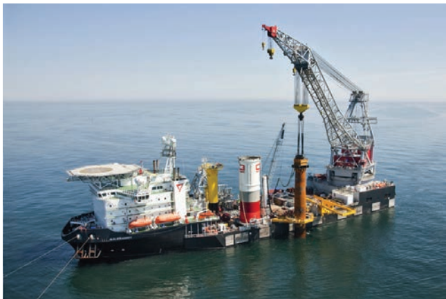
Рис. 12. Устройство моно-свай диаметром до 6.2 м с плавсредств для установки ветрогенераторов в Северном море
