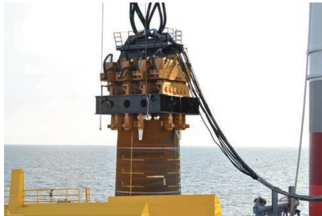
Рис. 13. Комплект из 4-х вибропогружателей VPE-600 для погружения в основание морского дна моно-свай диаметром до 6.2 м, длиной до 75 м
