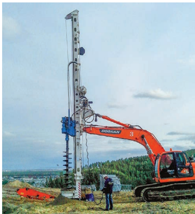
Рис. 1. НБО-05. Бурение непрерывным шнеком.
