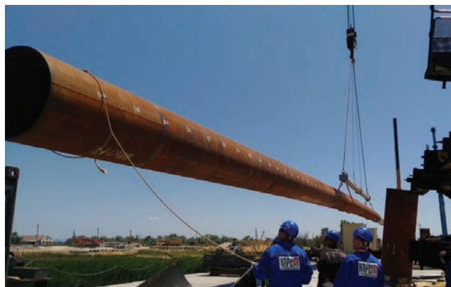
Рис. 2. Подъем краном со стапеля укрупненной сваи-оболочки диаметром 1420 мм
