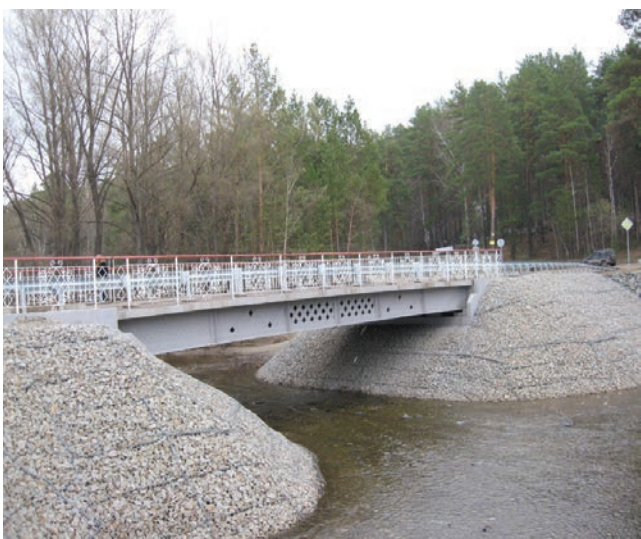
Рис. 1. Автомобильный мост через р. Пашенку на а/д «Красный Яр - Сосновка» в Новосибирском районе НСО
