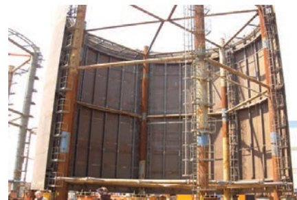
Рис. 8. Изготовление сваи-оболочки диаметром 22м, длиной до 47 м
