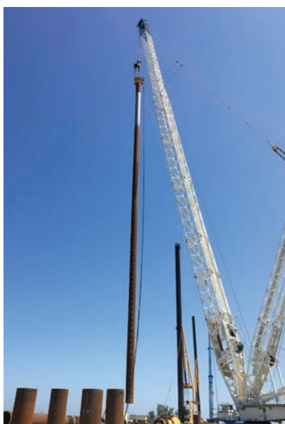
Рис. 4. Подъем сваи-оболочки диаметром 1420 мм, длиной 85 м в вертикальное положение
