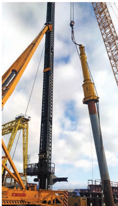
Рис. 7. Погружение наклонной сваи-оболочки диаметром 1420 мм при помощи молота MENCK MNU-440S
