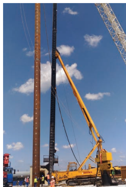
Рис. 5. Подача установки ИНС FUNDEX Equipment F15 с мачтой 46 м в месте погружения сваи-оболочки
