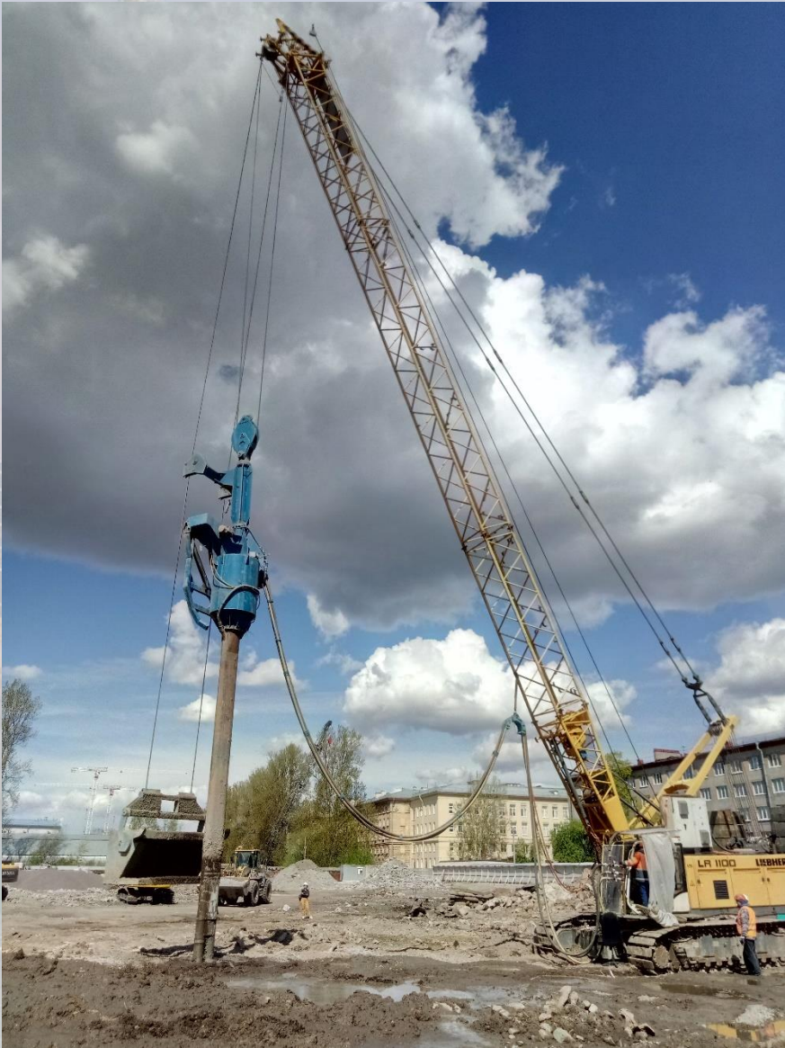
Процесс виброфлотации
