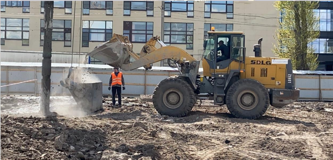
Погрузка щебня фронтальным погрузчиком
