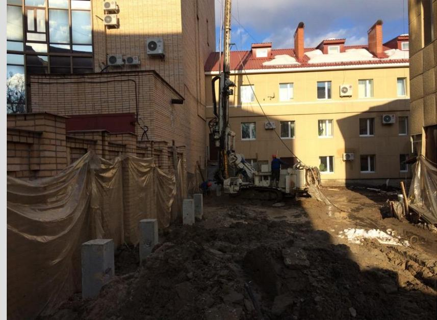
Конструкция представляет собой комбинированную сваю, включающую грунтобетонный столб и размещенный в нем сердечник. Сердечником сваи может быть металлический или железобетонный элемент. Сердечник служит для восприятия воздействий от сооружения и передачи ее через грунтобетонную рубашку на окружающий грунтовый массив.
