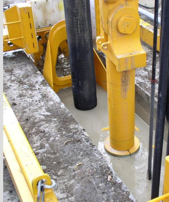
Элементы, выполняемые по этой технологии, используются в качестве ограждающих конструкций, воспринимающих давление грунта, подземной воды и полезные нагрузки.
