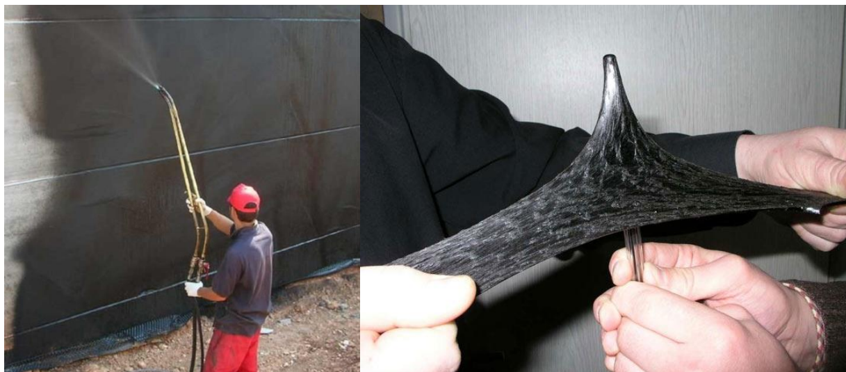
Рисунок 4. – Нанесение водонепроницаемой эластичной полимерной мембраны Rapidflex
