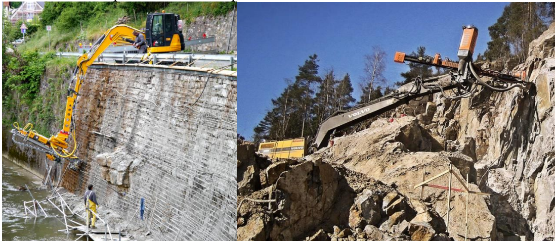
Рисунок 2 – Бурение шпуров с помощью навесного лафета
