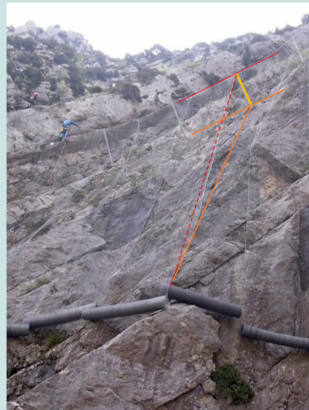
Монтаж противокампнепадной улавливающей завесы
