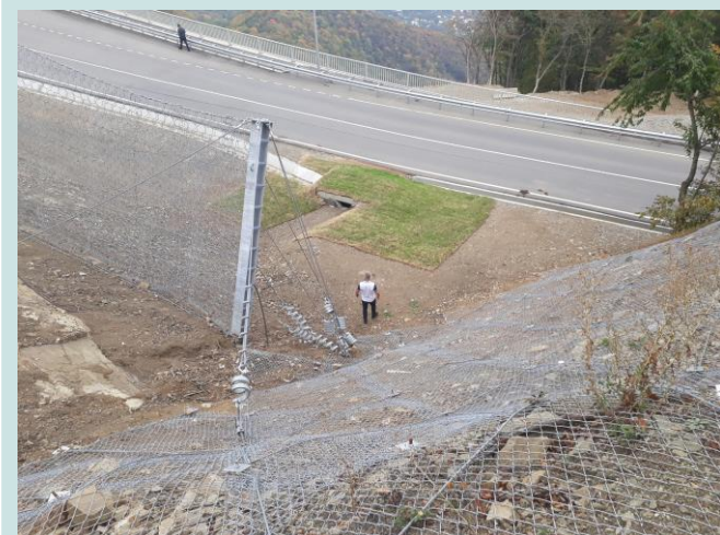
Противокампнепадные барьеры на автодороге Цхнети – Самadlo, Грузия
