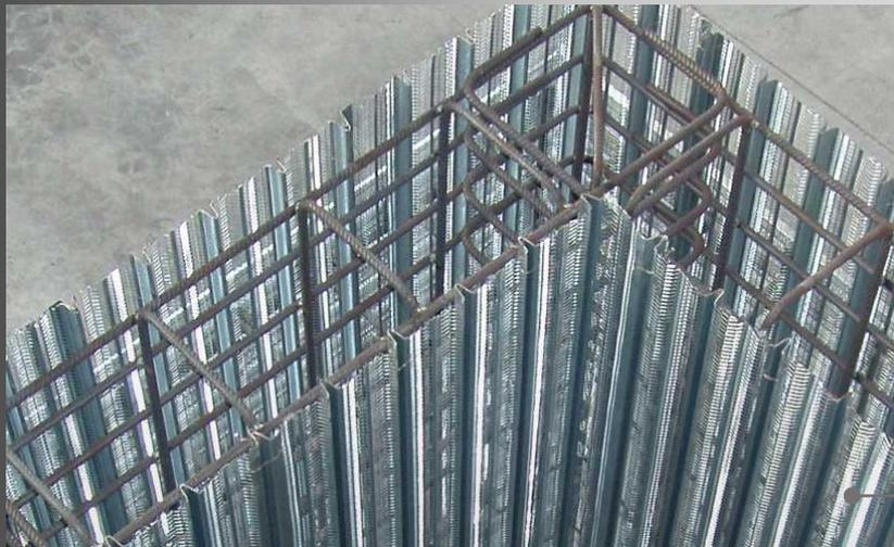
Рёбра жесткости принимают на себя нагрузку от давления бетонной смеси и позволяют сохранять геометрию конструкции
