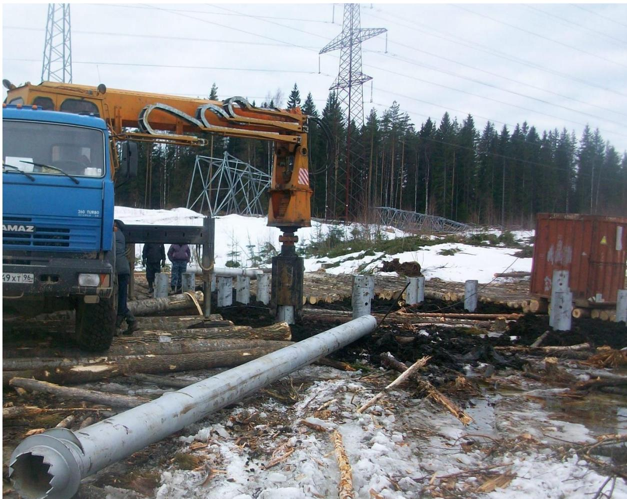
Рис. 4. Применение винтовых свай с открытым сварным наконечником в условиях немёрзлых грунтов при строительстве заходов на ПС 330 кВ «Зеленогорск»
