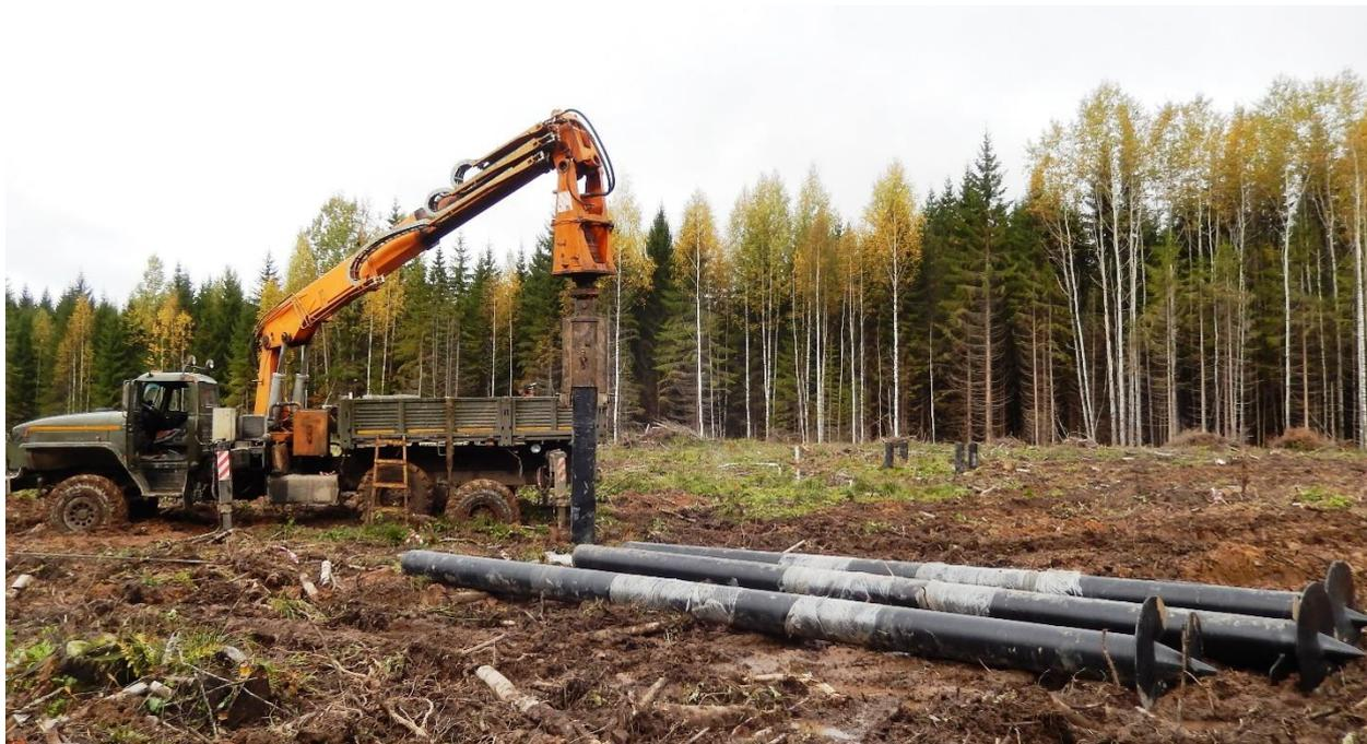
Рис. 3. Стальные винтовые сваи марки ВСЛ 85032512 (диаметр лопасти 850 мм, диаметр ствола 325 мм, длина 12 м) по ТУ5264-005-82096320-2013 с закрытым литым наконечником, завинчиваемые при помощи универсальной буровой машины УБМ-85
