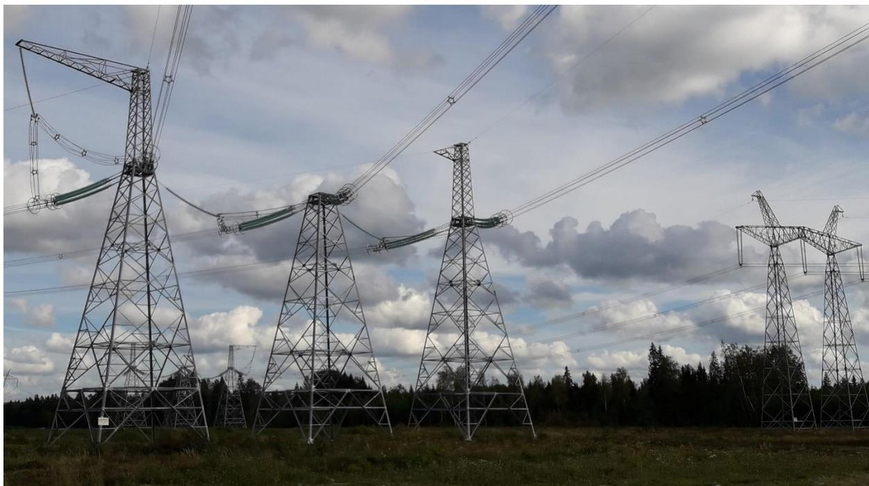
Рис. 2. Воздушные линии электропередачи, отходящие от ПС 750 кВ Ленинградская: слева – построенная ВЛ 750 кВ «Ленинградская – Белозерская» (оп. №1400), справа – ВЛ 750 кВ «Ленинградская – Калининская АЭС»
