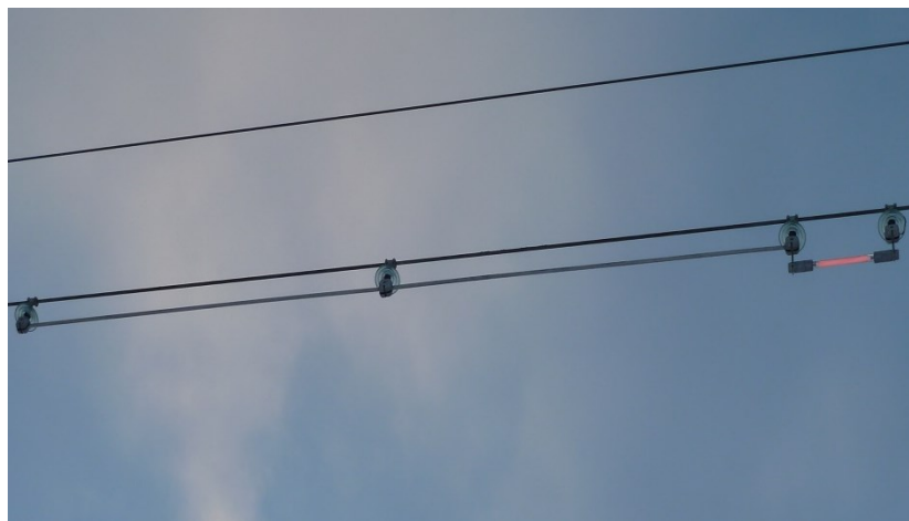
Устройства маркерного типа для обозначения проводов в темное время суток
