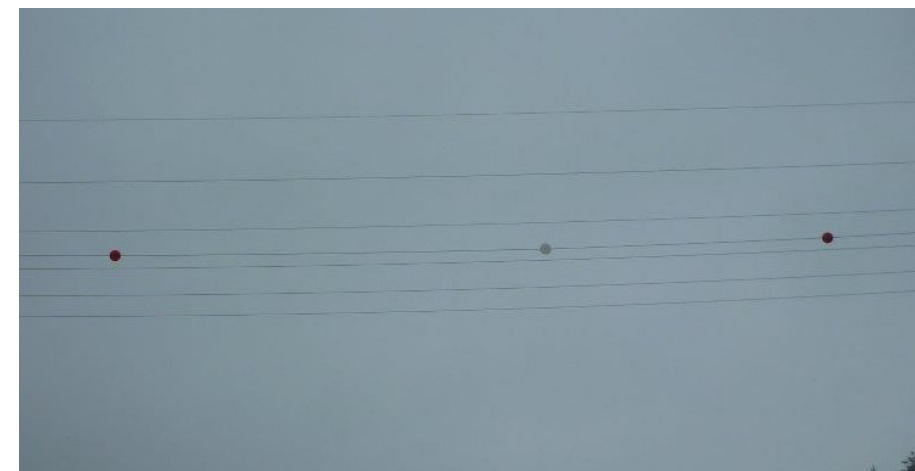
Шары-маркеры для обозначения проводов и тросов в светлое время суток
