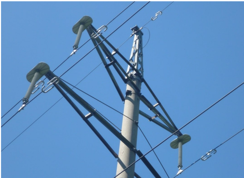
Экран ЭПЗУ для защиты изоляции от загрязнения
