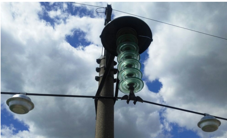
ПЗУ барьерного типа Пневматические гасители вибрации
