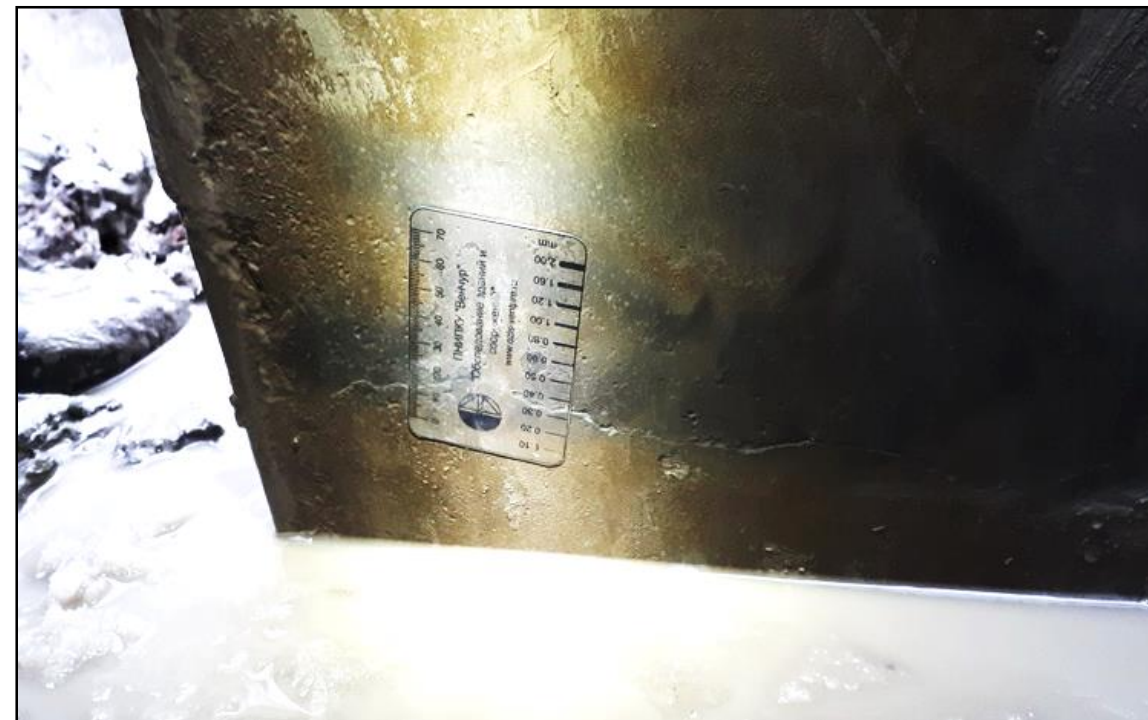
Трещина раскрытием 0,3 мм на глубине 1,6 м
