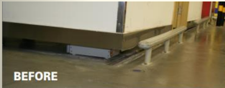
Стабилизация просевших полов и фундаментов в коммерческом центре, Восточная Финляндия.
