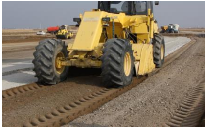
Плоскостное укрепление грунта и холодная регенерация
