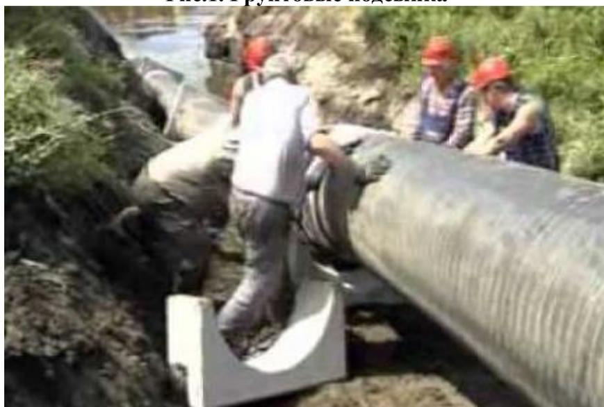
**Рис.2. Железобетонные блоки**
