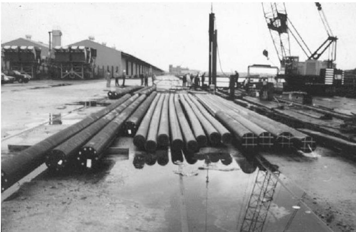
Рисунок 4 - Сваи, готовые к установке в порту Ньюарк.
