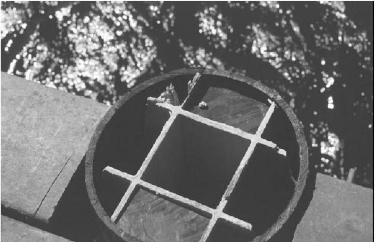
Рисунок 3 - Полимерная свая конструкции Creative Pultrusions, установленная в рамках программы SPAR на пирсе на улице Тифани.
