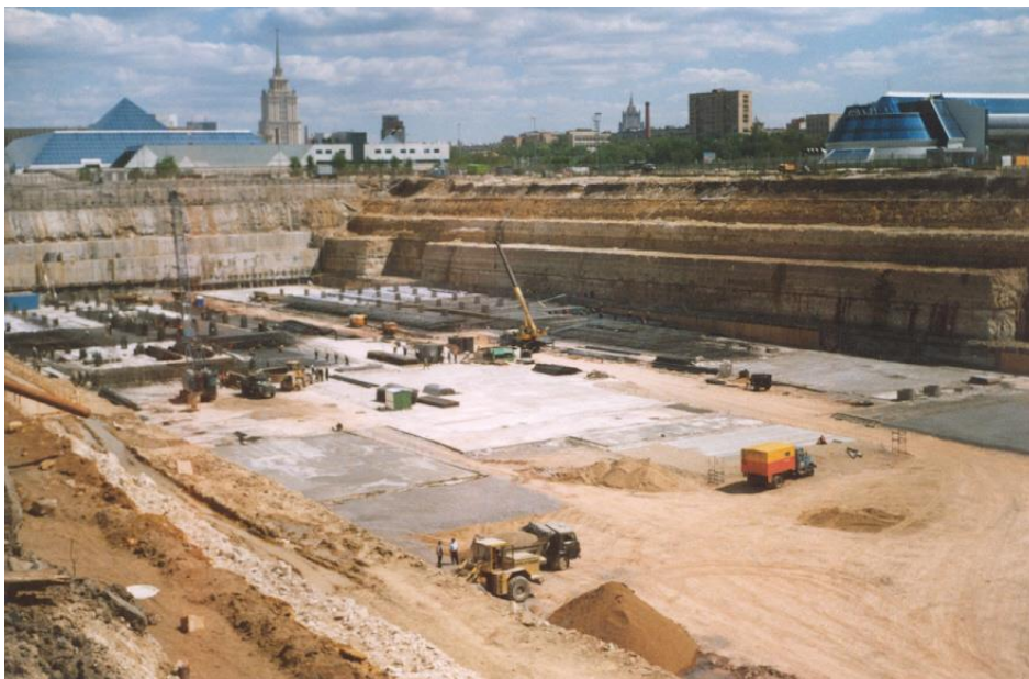
Рис. 6. Общий вид котлована Центрального ядра, 1999г.
