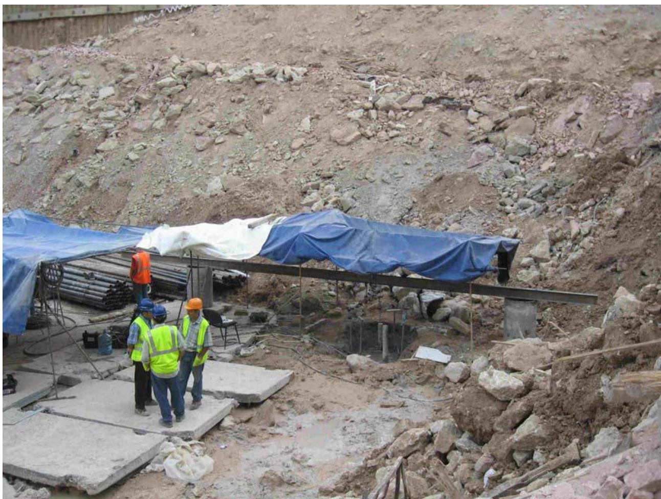
Рис. 43. Площадка с испытываемой свайей.
