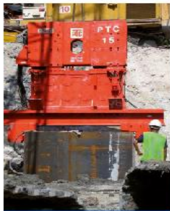
Наголовник Duplex с прямой балкой для погружения обсадных труб большого диаметра (в основном используется с наголовниками типа Duplex)
