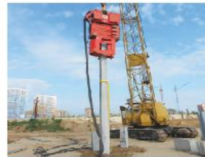
Вибропогружатель 30HV с наголовником типа Multigrip погружает 350-мм сваи квадратного сечения на строительной площадке в России.
