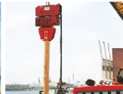
Вибропогружатель 30HV погружает деревянные сваи на территории подкадного канала пристани для яхт в Гамбурге (Германия).
