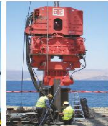
Универсальная комби- плата для быстрой смены зажимных наголовников (Agridplex - Duplex) при работе со шпунтовыми сваями и трубами
