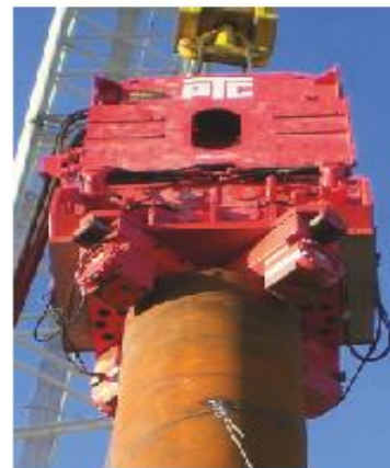
Наголовник Quadriplex с переходной плитой IRASCO для труб и колонн малого и среднего диаметров при работе большими вибропогружателями
