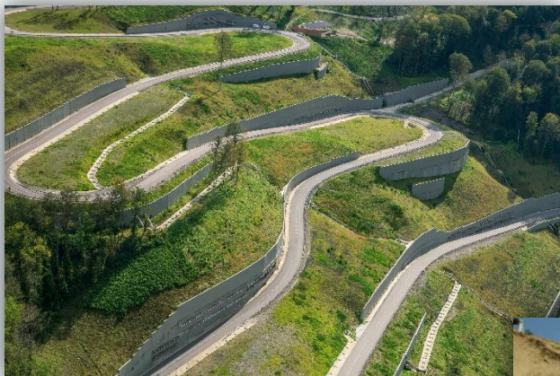
На свайном основании
