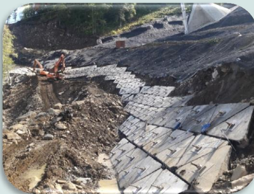
Нагельное крепление с прижимными плитами
