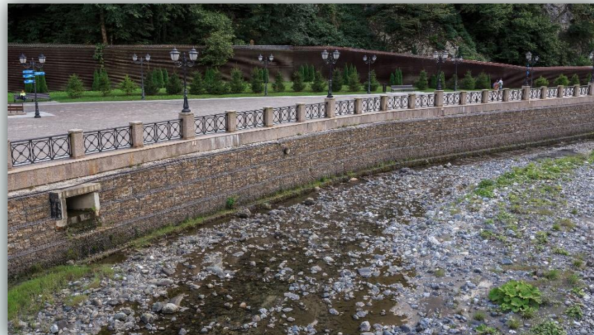
Подпорные стены из габионов
