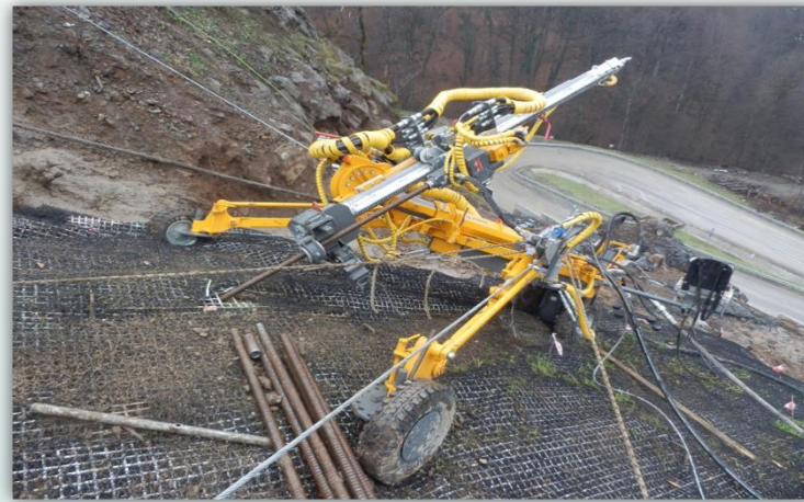
Мобильная установка с тросовым креплением для бурения на отвесных склонах
