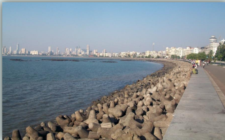
Гибкое волногасящее сооружение с применением тетраподов
