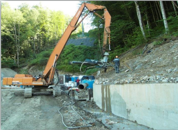
Навесное бурильное оборудование на базе экскаватора
