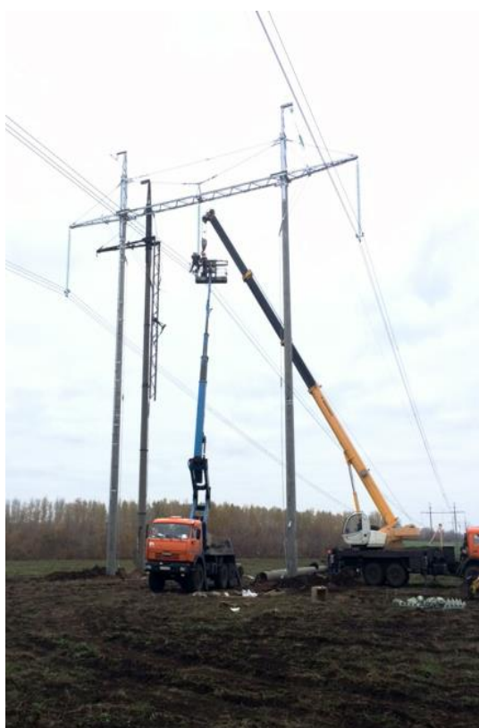
Рис. 1. Замена опоры ПБ500-5н на ПБ500-5н(с) на ВЛ 500 кВ Тамбов - Пенза 2
