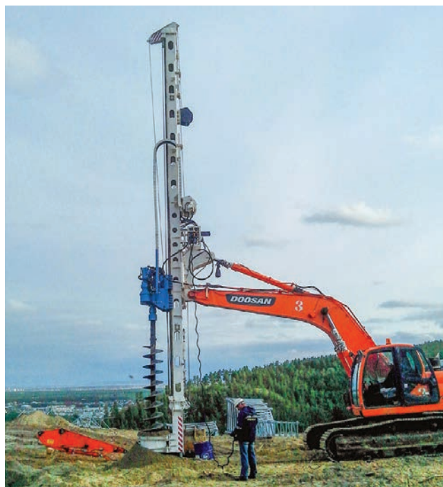
Рис. 1. НБО-05. Бурение непрерывным шнеком.
