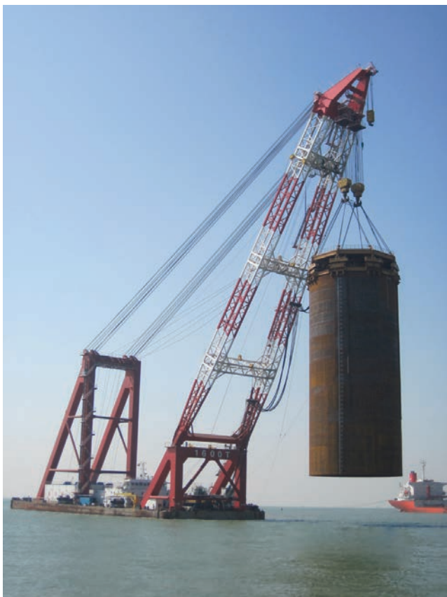
Рис. 10. Погружение оболочки диаметром 22 м, длиной 47 м с плавкрана грузоподъемностью 1600 т
