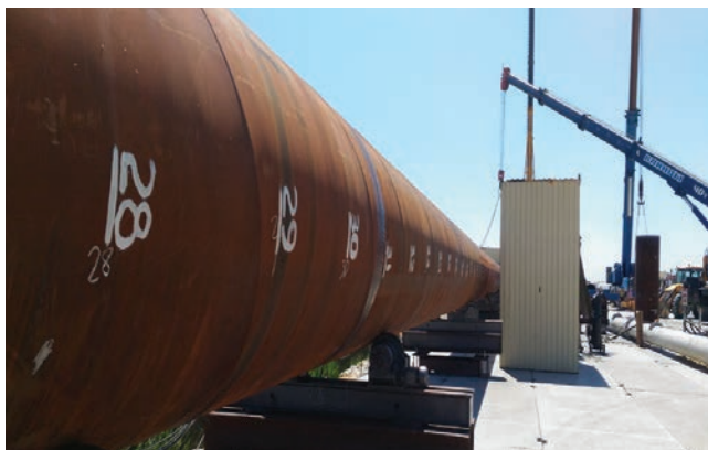
Рис. 1. Укрупнение сваи-оболочки из отдельных секций диаметром 1420 мм на стапеле
