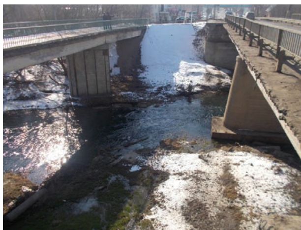
Рис 7. Мост через реку Плава в г. Плавск Тульской области
