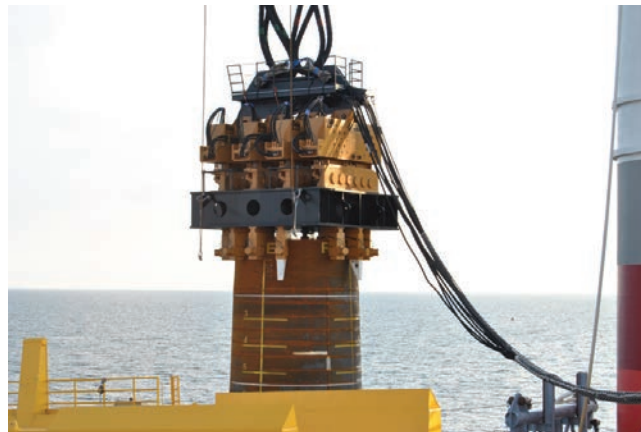
Рис. 13. Комплект из 4-х вибропогружателей АРЕ-600 для погружения в основание морского дна моно-свай диаметром до 6.2 м, длиной до 75 м
