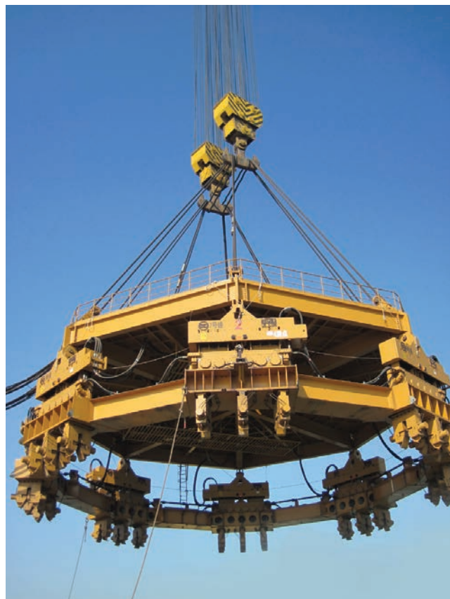
Рис. 11. Погружение оболочки диаметром 22 м, длиной 47 м с плавкрана грузоподъемностью 1600 т
