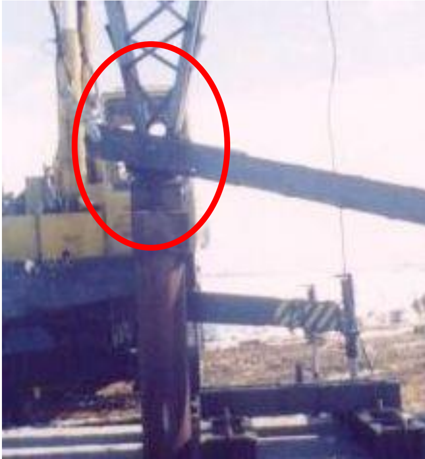
Захват опорного узла стойки опоры
