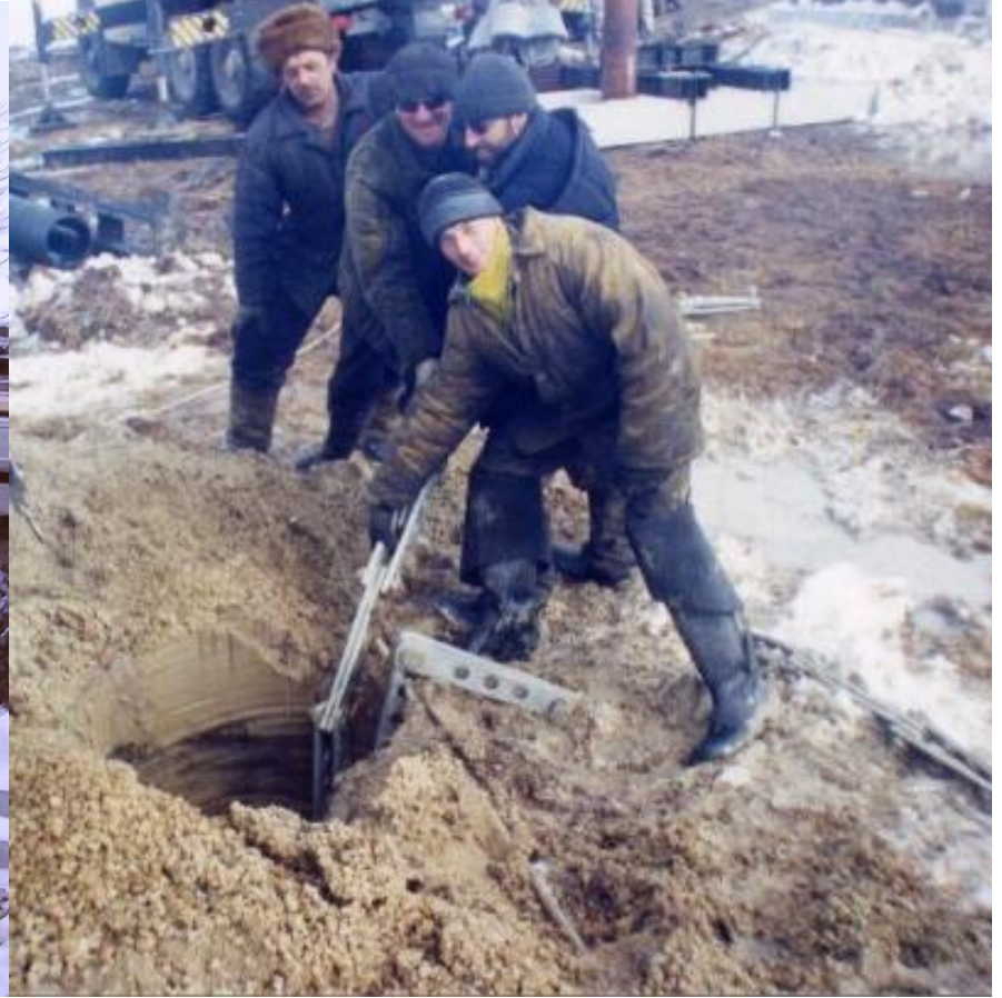
Установка анкерного устройства для крепления оттяжек промежуточной опоры
