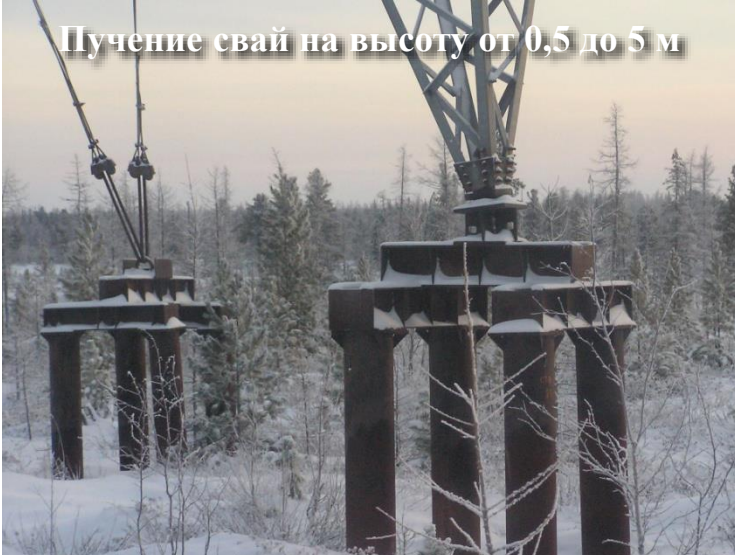
Неравномерное пучение свай под опорой
