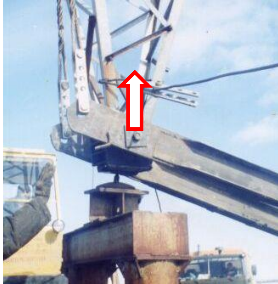
Подъем стойки опоры с опорного узла фундамента
