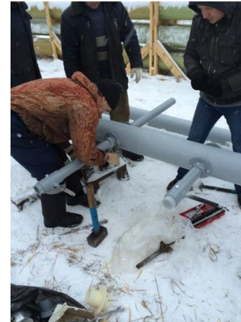
Сборка опоры ПК10-2
