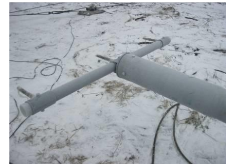
Узел крепления траверсы после испытаний опоры ПК10-2И
