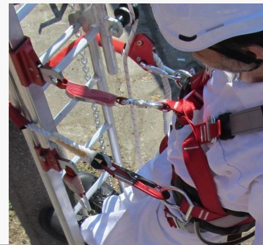
Рис. 9 Основные элементы составной лестницы
