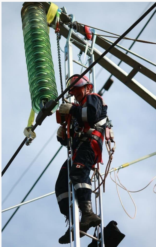
Рис. 15 Подвесная лестница для работы на изоляторах. Международные соревнования электромонтеров в г. Бресте.
