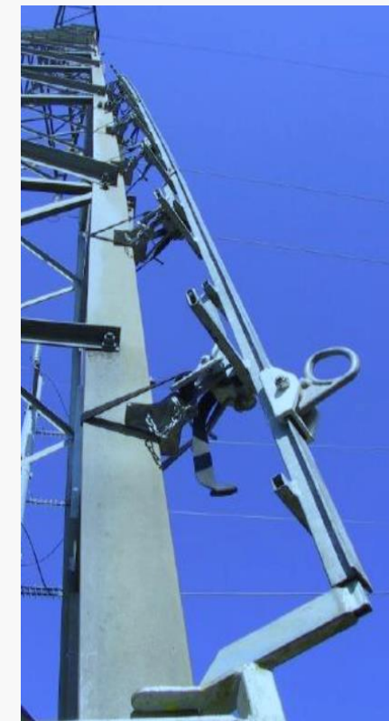
Рис. 7 Стационарная лестница с жесткой анкерной линией и устройством ползункового типа
