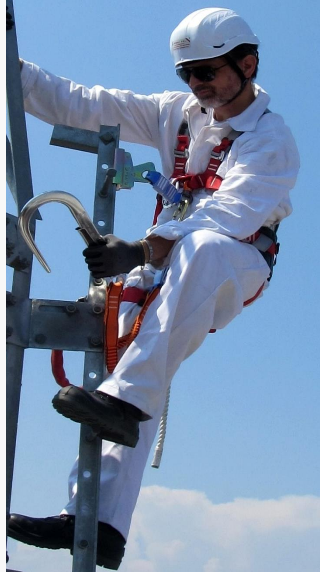
Рис. 3 Метод подъема на по новым опорам со встроенной лестницей с жесткой анкерной линией
