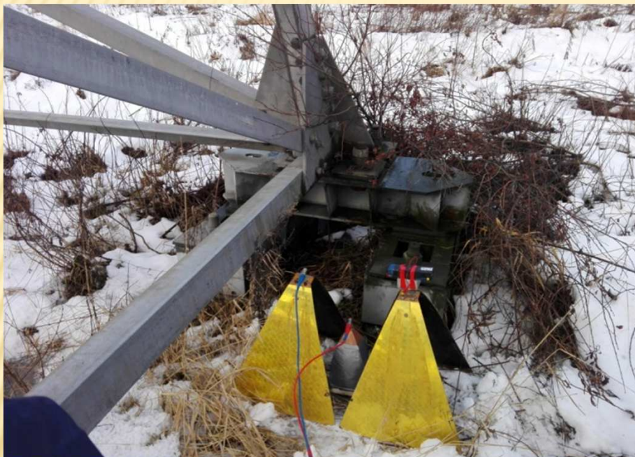
Комплекс «Геодизонд-1» в пункте зондирования ТЗ-1 вблизи сваи
