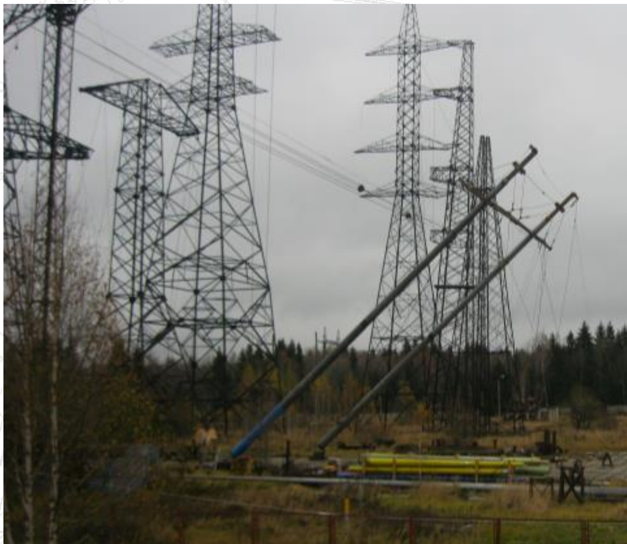
Подъем опоры 2СПБ500-3В
