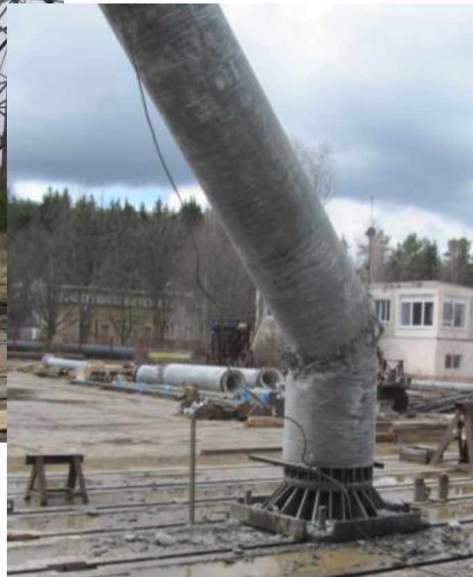
Разрушение стойки СЦС20В 40.2 (152%)
