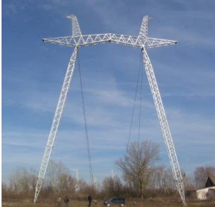
Самая «массовая» промежуточная опора ВЛ 500кВ ПП500-5.
