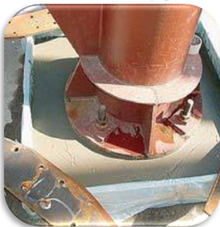
Установка перильных ограждений
