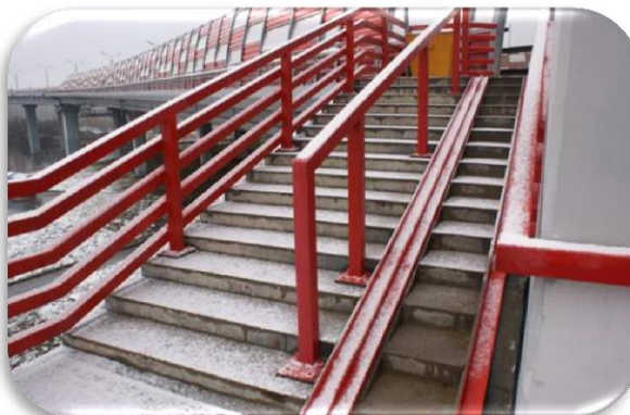
Установка перильных ограждений
