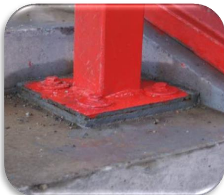
Установка перильных ограждений
