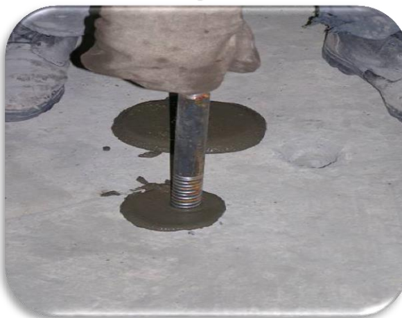
Установка перильных ограждений
