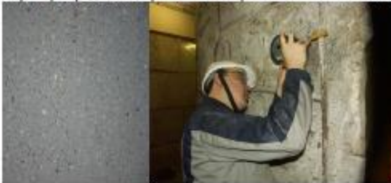
Фотография 1. Внешний вид подготовленной бетонной поверхности и пример определения прочности на отрыв бетонного основания
