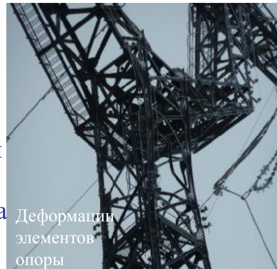
Переходная опора ПС-90 № 23 после динамического удара
