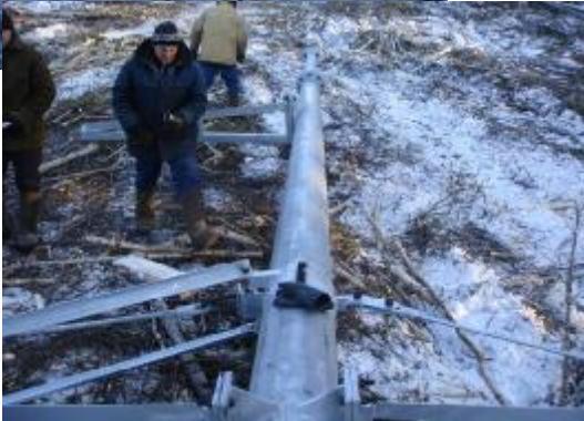
Стыковка секций, монтаж траверс и тросостойки
