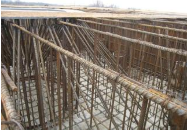
Арматурный каркас ростверка
