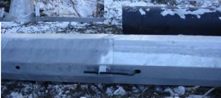
Стыковка секций, монтаж траверс и тросостойки
