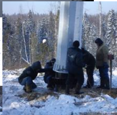
Установка опоры на фланец фундаментной секции
