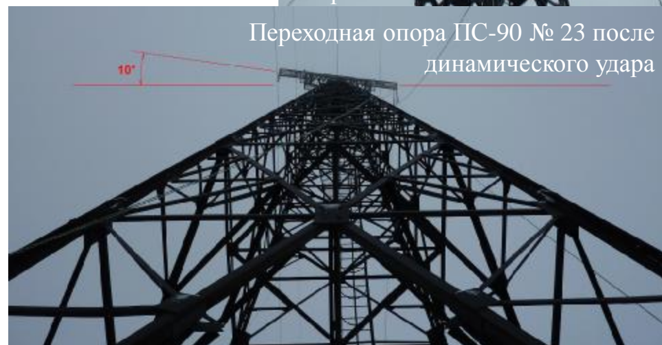
Деформации элементов опоры
